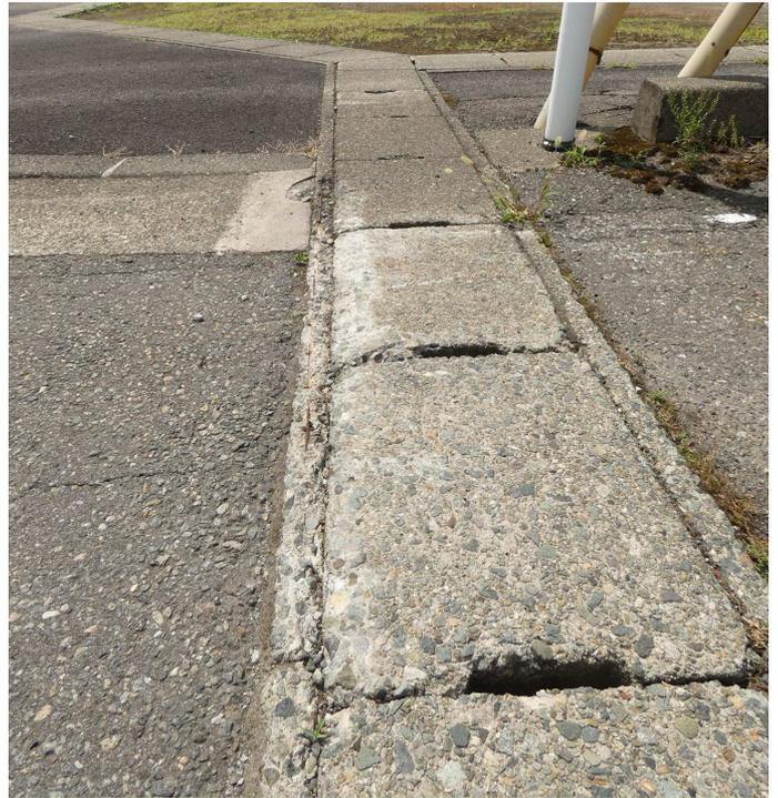
これは車両の通行や除雪車などによって側溝本体のふた掛かり部分、ふた板の表面が削られる現象です。側溝本体の鉄筋が露出したり、ふた板の厚さが薄くなるなど安全面でも懸念され、ここまでくると簡単には直せない状態です。
