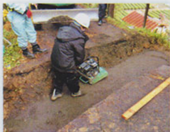
① 基礎材敷設
