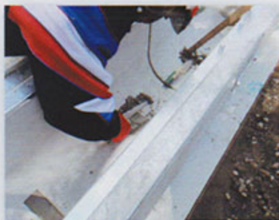
⑤ 連結部モルタル詰め
