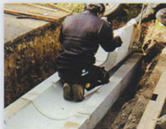
③ 側溝据え付け
