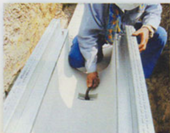
④ 固定ボルト締め
